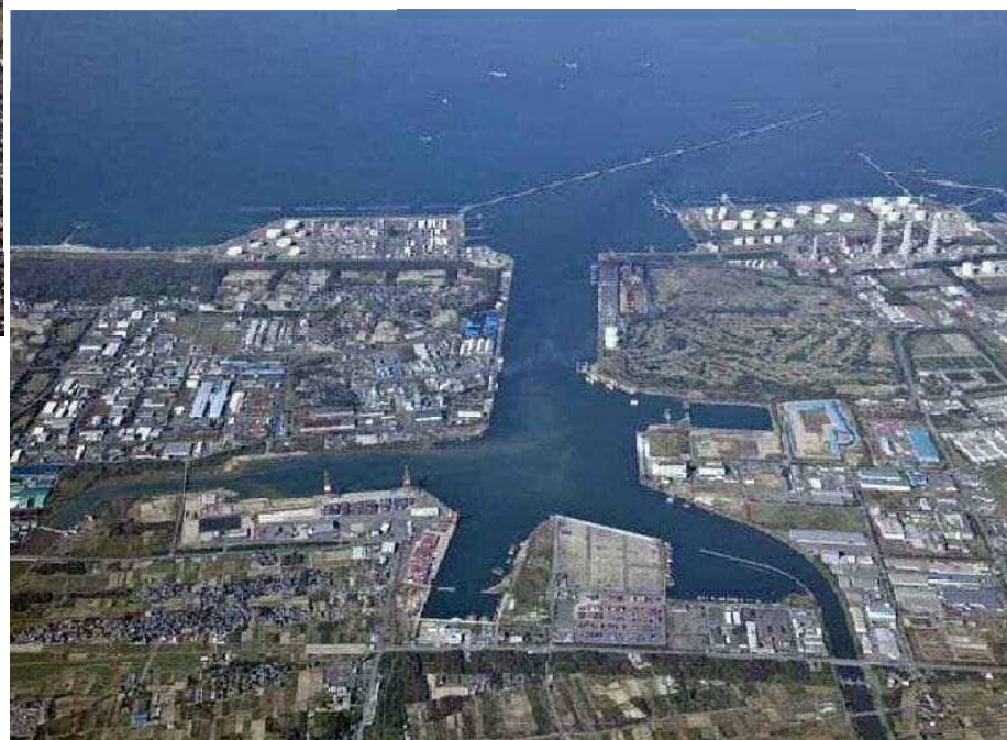
新潟港（東港区）
