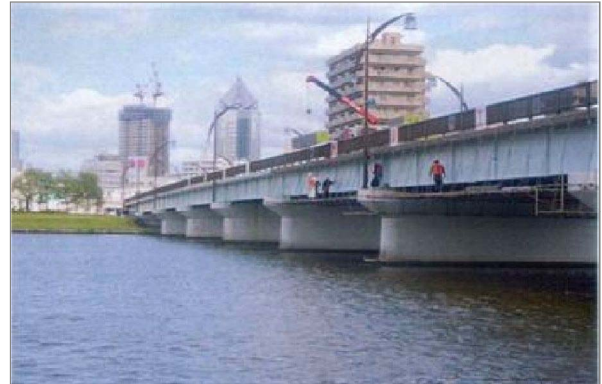
▲ 橋梁点検(八千代橋)
