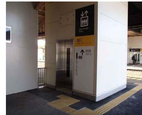
荻川駅（H26改札内エレベーター整備）
