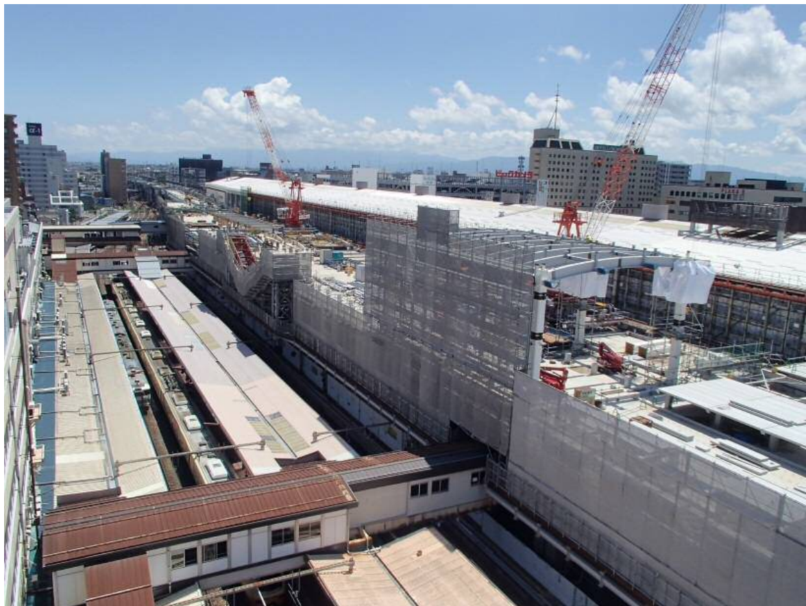
新潟駅部の高架化工事
