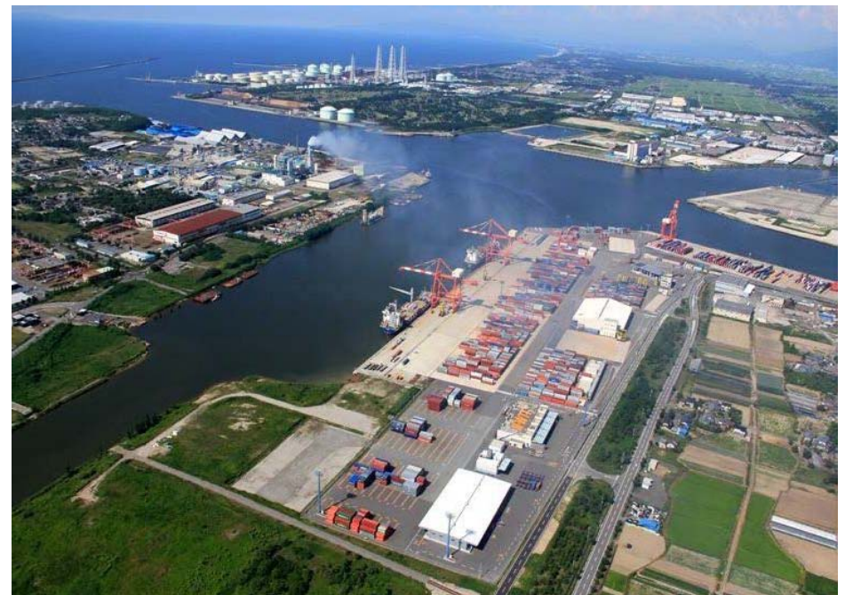
新潟港（東港区）
