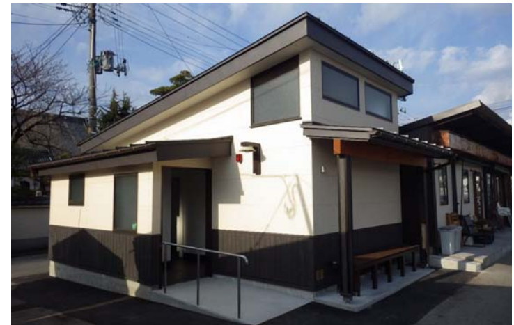
沼垂東公衆トイレ(平成29年3月竣工)
