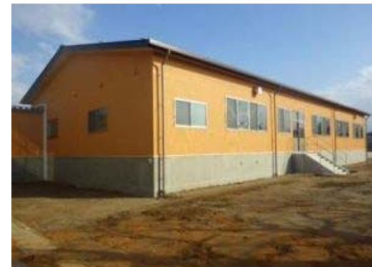
建物外観(西面)
