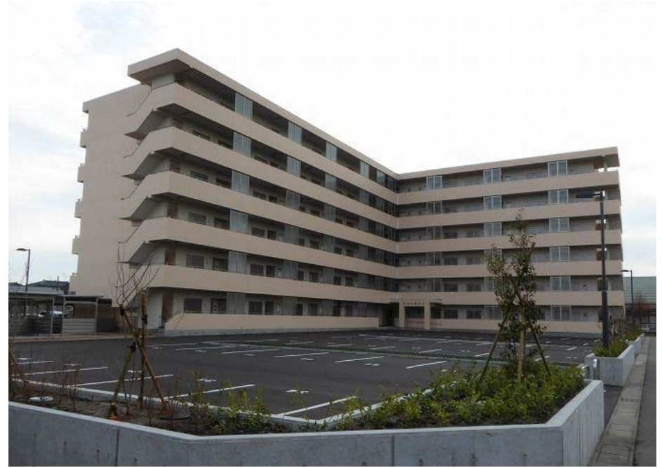
亀田向陽住宅
