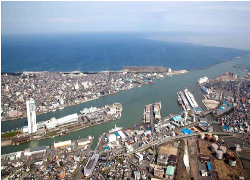
新潟港（西港区）
