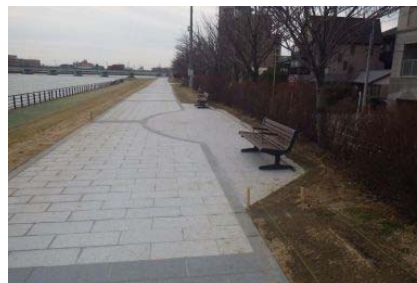
やすらぎ堤 視点場整備
