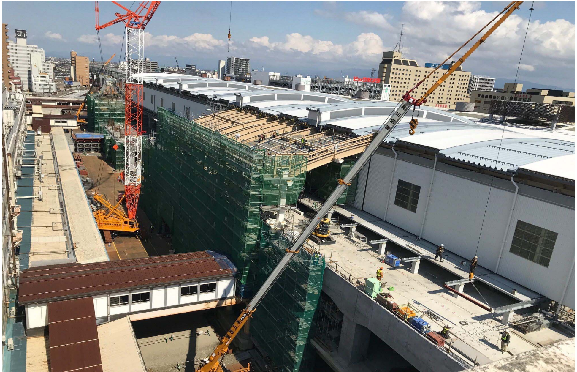
鉄道高架化完成に向け第二期高架橋工事中の新潟駅
