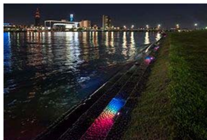
やすらぎ堤 景観照明
