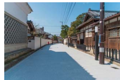
白壁通り 道路改良工事
