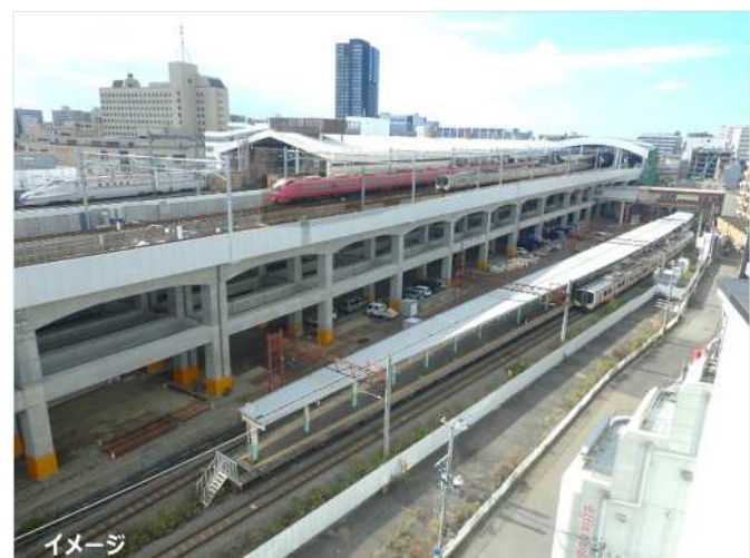
在来線高架化工事の整備状況
