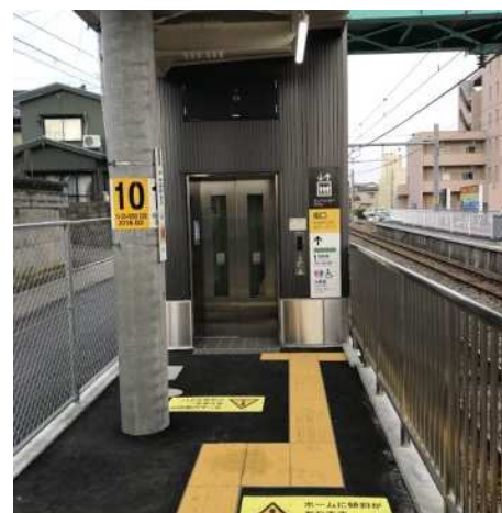
JR 越後線小針駅 (H30改札内エレベーター整備)
