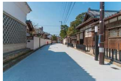
白壁通り 道路改良工事
