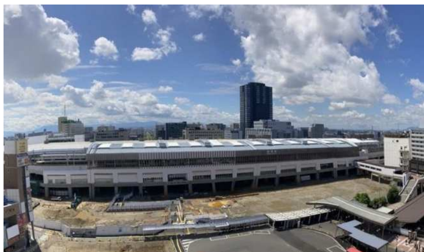
万代広場整備に向けた新潟駅万代口駅舎の撤去の様子
