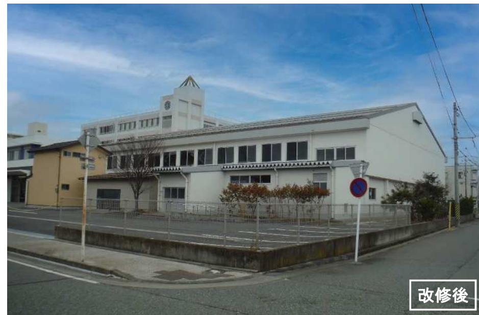
北部総合コミュニティセンター体育館棟 外壁・屋根改修工事
