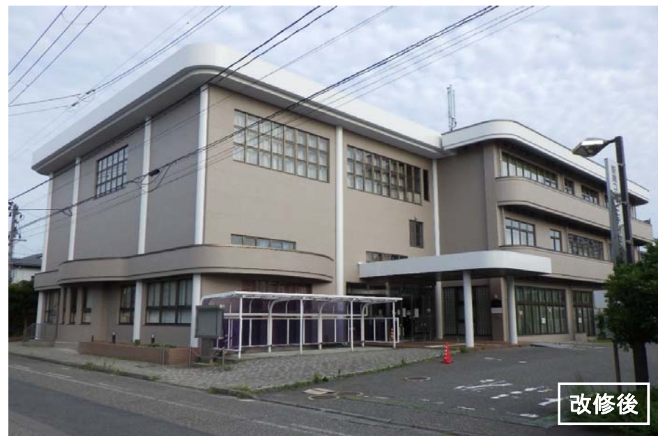
駅南コミュニティセンター外壁改修工事
