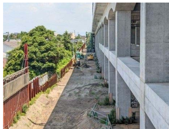
在来線高架化工事（仮線路撤去後）の状況
