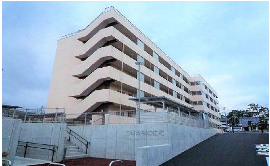
古町みなと住宅
