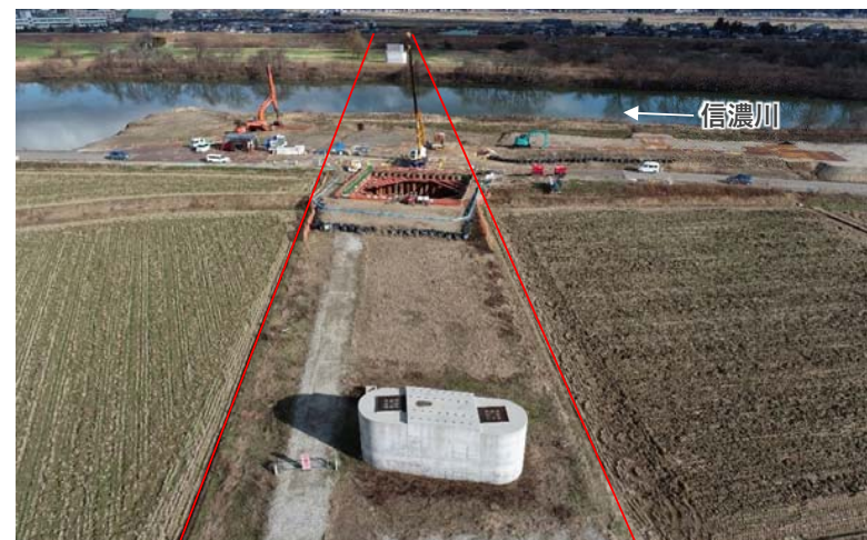
(主)白根安田線(小須戸橋)
