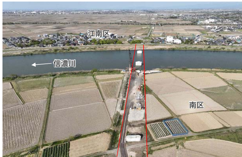
(主)新潟中央環状線(信濃川渡河工区)
