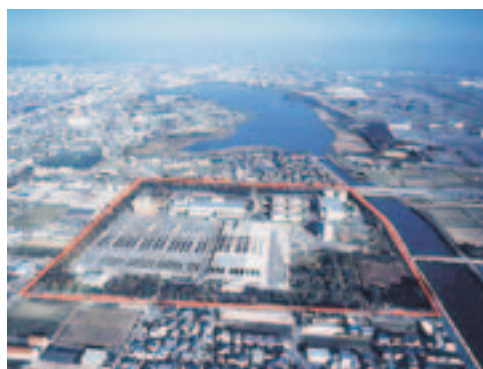
中部下水処理場
