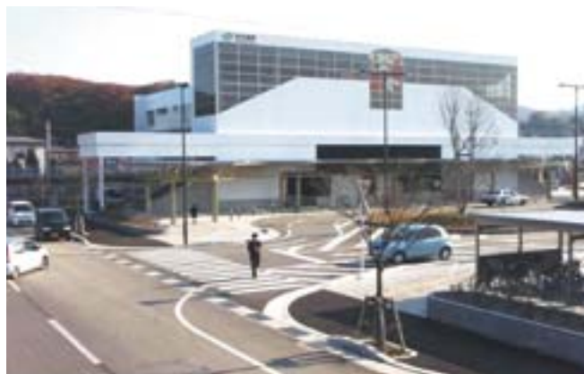
JR信越本線 矢代田駅 西口広場 (平成21年度供用)
