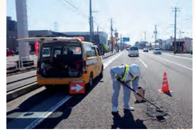
舗装補修の状況
