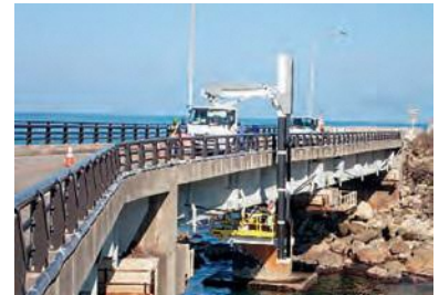
橋梁点検の状況
