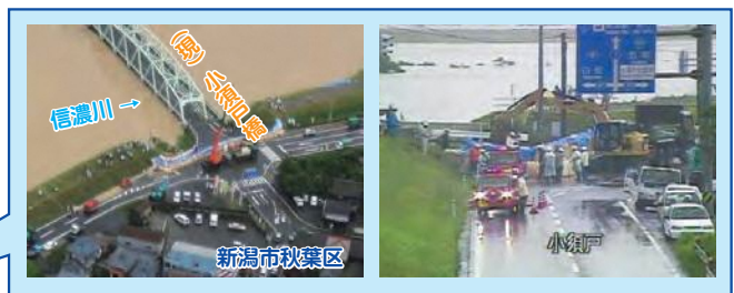
新潟福島豪雨時の出水状況と水防活動 (H23.7.30)
