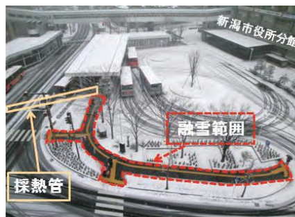
下水熱を利用した歩道融雪状況
