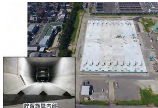
中部下水処理場 貯留施設
