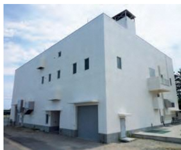
ポンプ場外観
