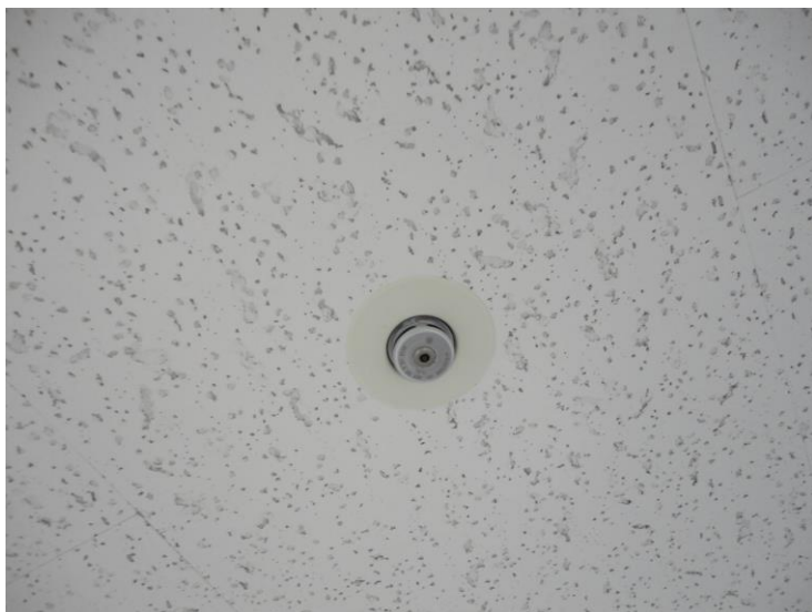
スプリンクラーヘッド（天井埋込形）
