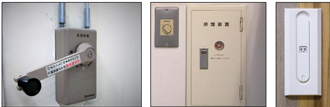
自然排煙における手動開放装置（オペレータ）
