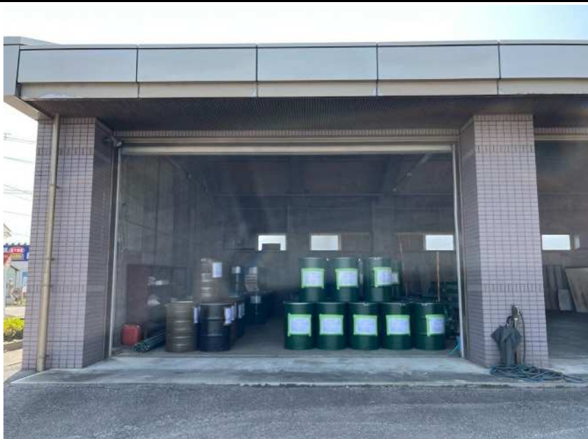
写真② 保管場所(倉庫左側)
