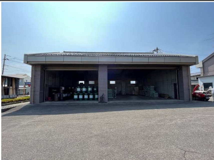
写真① 保管場所(全景)
