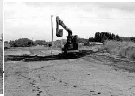
5月重機による整地作業
