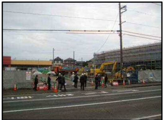
【写真6】出入口 (9 m道路)
