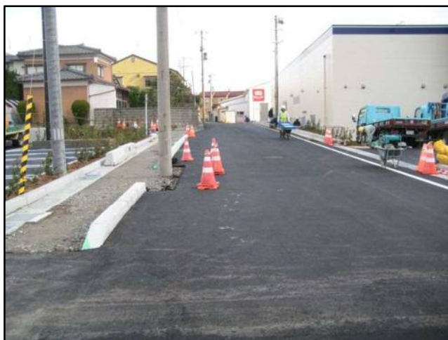
店舗間道路 (西→東)
