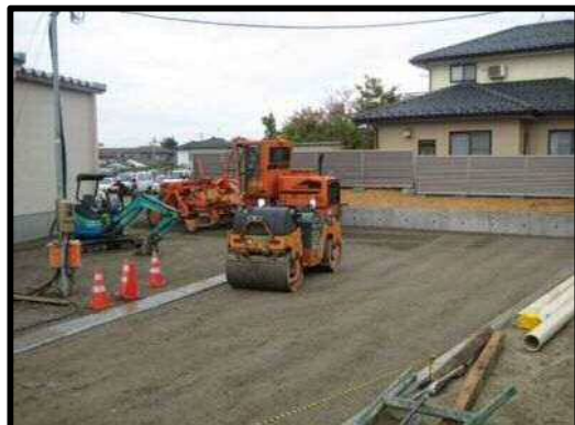
【写真23】従業員駐車場 (店舗裏側①)
