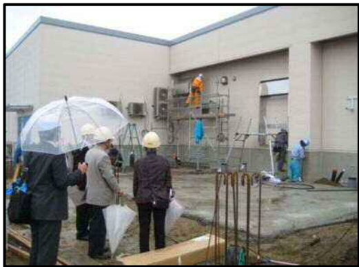
【写真28】室外機①
