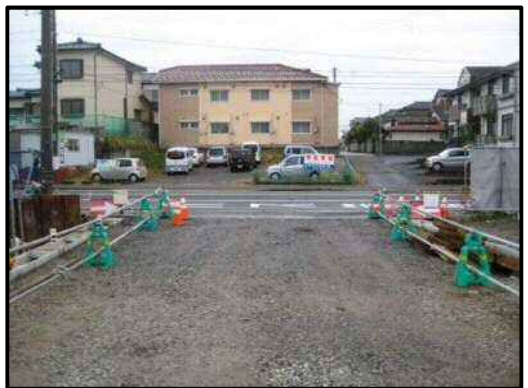
【写真8】出入口 (9 m道路)
