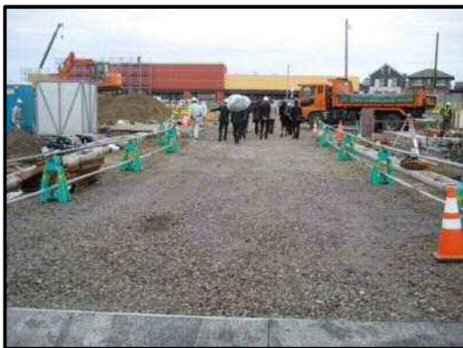
【写真7】出入口 (9 m道路)
