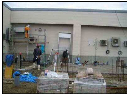
【写真29】室外機前遮音壁 (基礎工事中)
