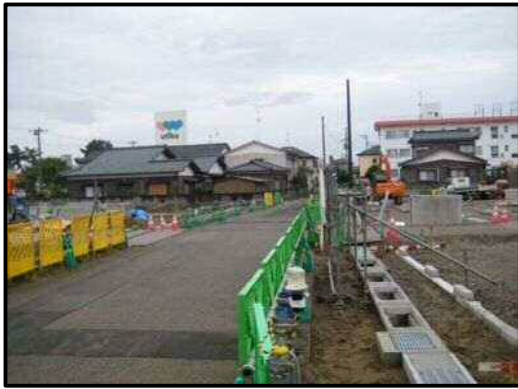
【写真 1 1】市道2-49号線拡幅
