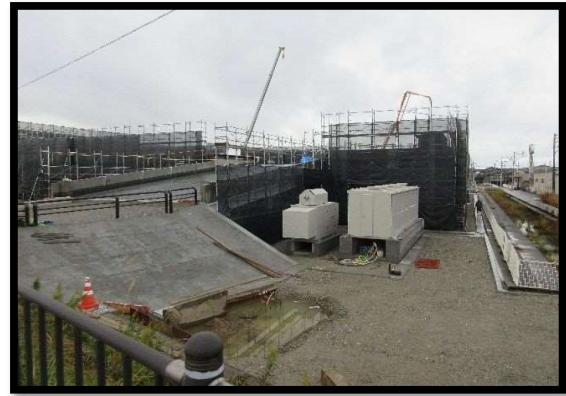
【写真⑩】 店舗北東側 室外機置場及び出入口 1
