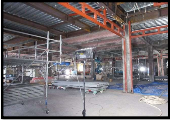
【写真⑰】 建物 1 階内部
