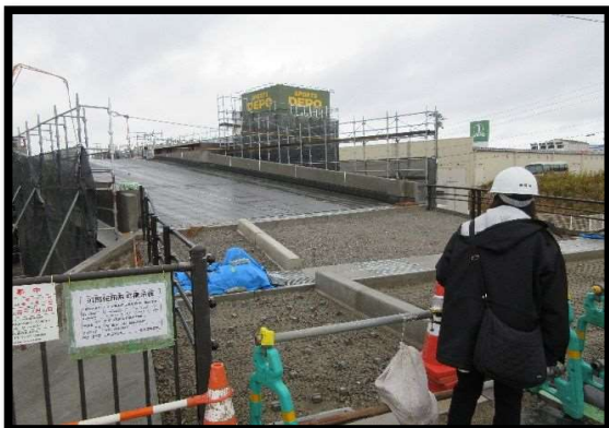
【写真⑦】 出入口 1
