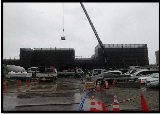
【写真①】 建物正面及び駐車場A (平面駐車場)
