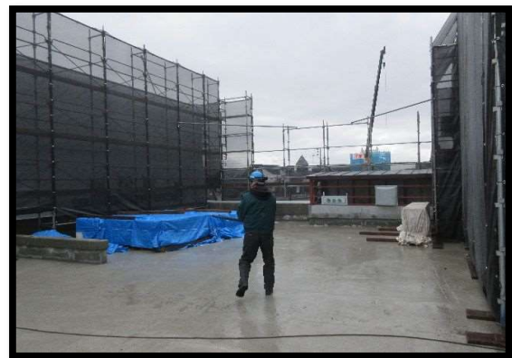
【写真⑯】 屋上室外機置場
