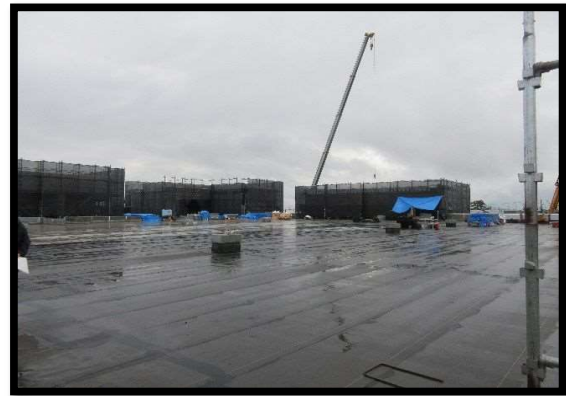
【写真⑫】 駐車場 B (屋上駐車場)
