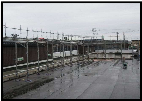
【写真⑬】 屋上室外機置場
