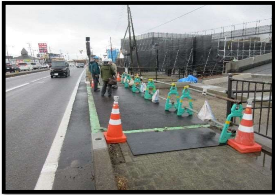
【写真⑨】 出入口 1
