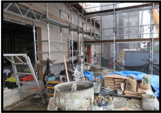
【写真⑲】 廃棄物保管施設
