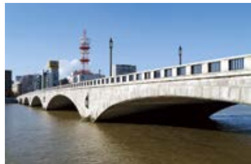
重要文化財 萬代橋
