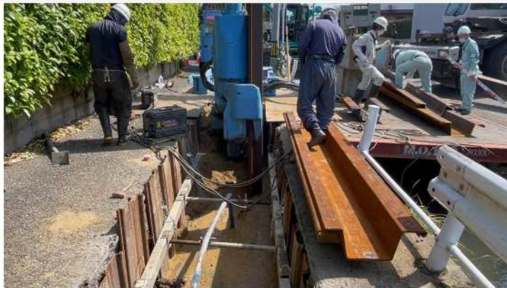
遮水矢板打込み状況
