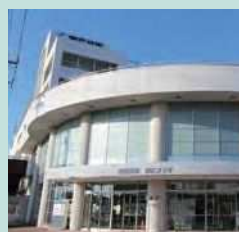
南口エントランス
