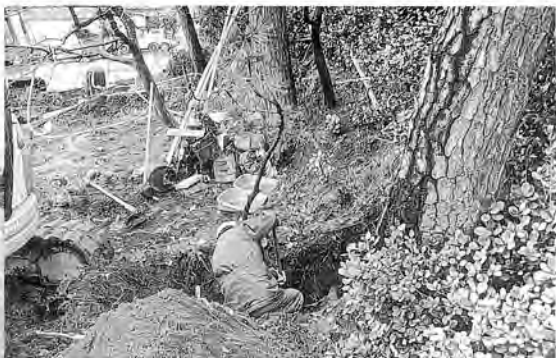
2 緒立城館跡調査風景(「土塁」部分、11T)
