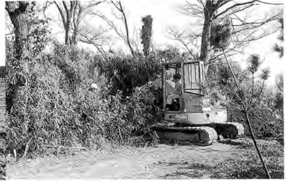
22 観音原遺跡調査風景(神社境内、8 T)
