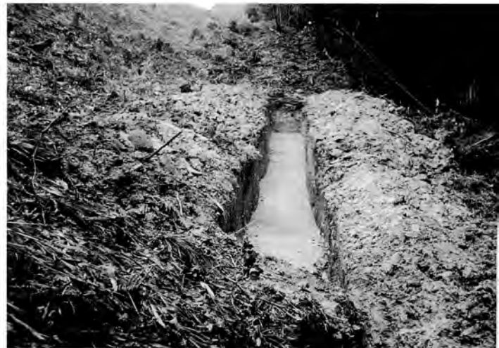
4T 完掘状況 (西から)
