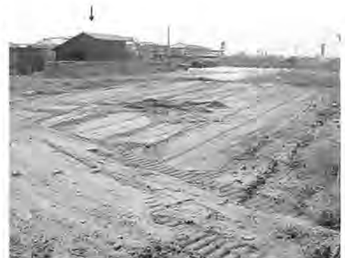
写真1 緒立B遺跡調査地（北東から） ※矢印は平成5年度調査地
