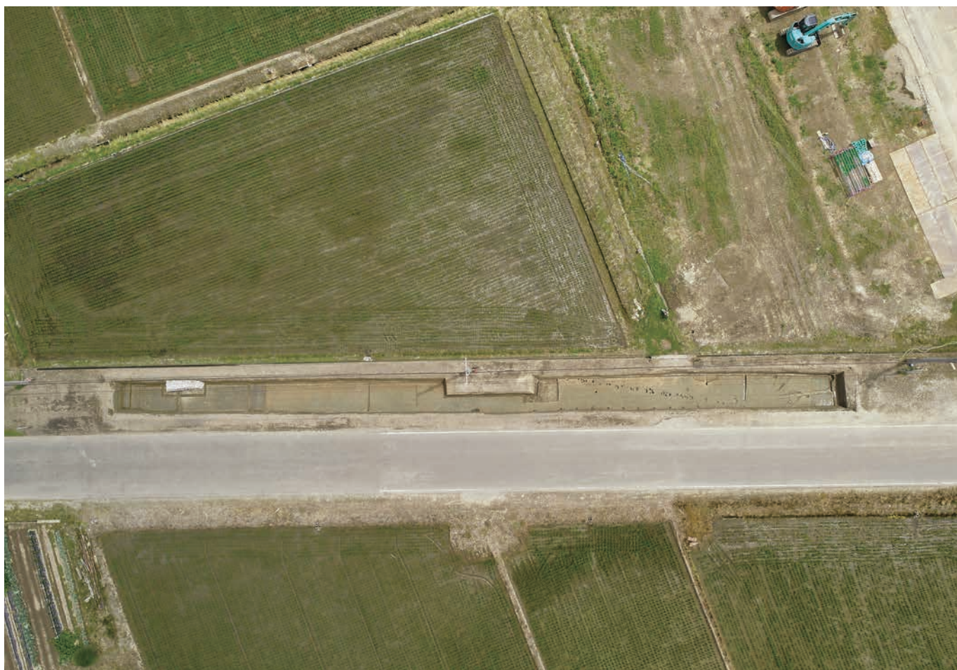
路線部分 完掘（上が北東）
