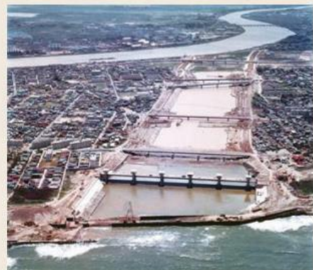
通水直前の関屋分水路 (信濃川下流河川事務所蔵)
