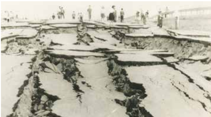
▲写真① 昭和大橋の地割れ（新潟市） 資料番号：50000634
