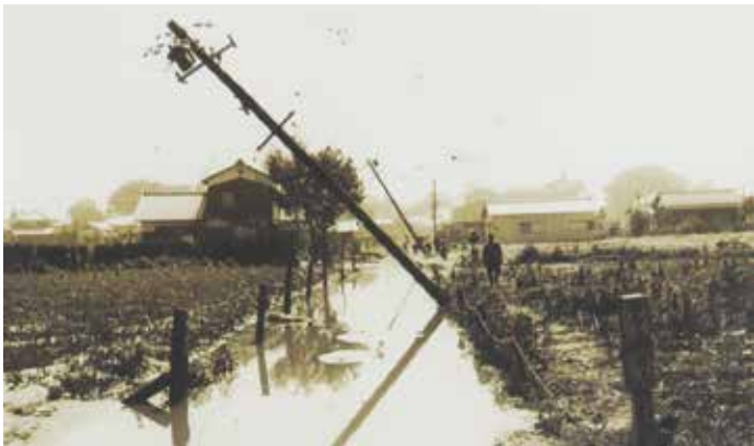
▲写真② 村道の陥没と地下水の噴出（黒埼村） 資料番号：30010036
