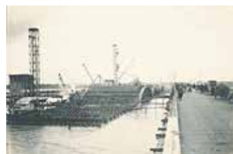
▲ 建設中の三代目萬代橋 (資料番号 50003794)
