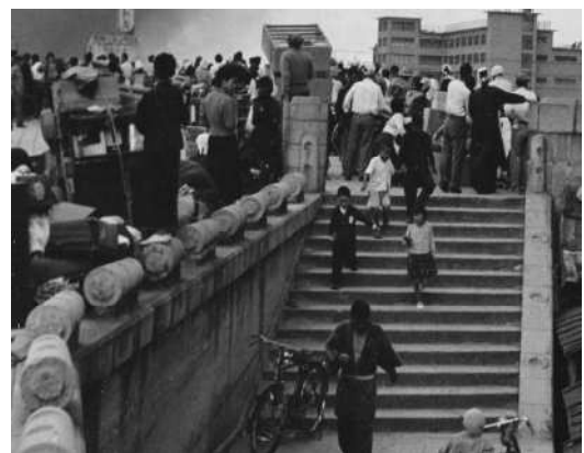
鉄管の欄が抜かれた萬代橋（当館所蔵） 昭和30年の新潟大火時の写真（部分）
