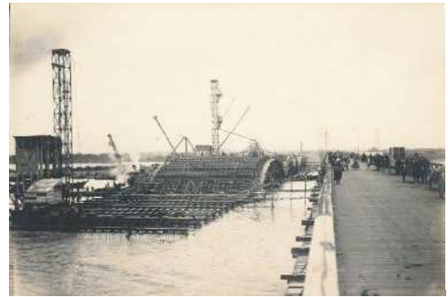
工事中の三代目萬代橋（当館所蔵） 特徴的なアーチ部分が形作られている
