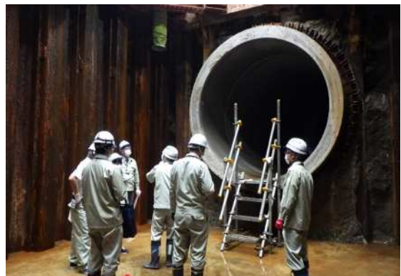
雨水貯留施設の整備
