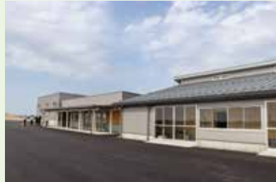
防災ステーションが、ついに完成!
