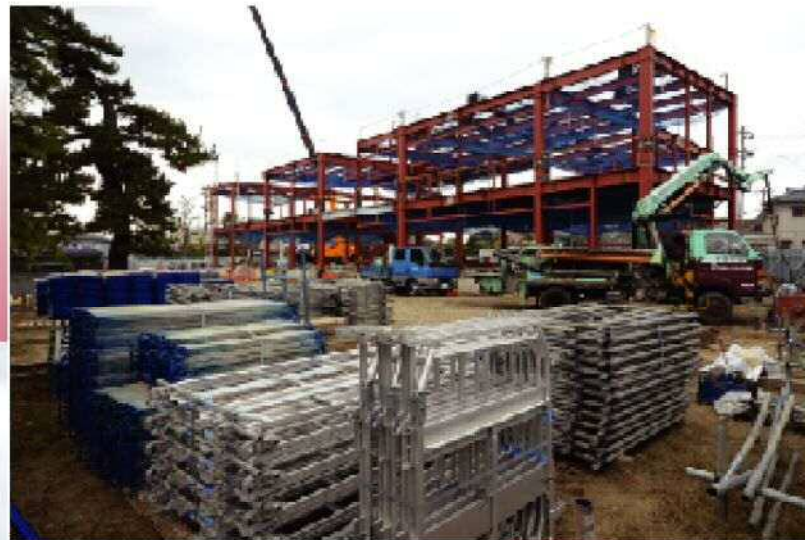
コミュニティセンター建設中
