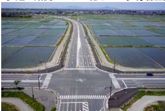
新潟中央環状道路 横越バイパス
