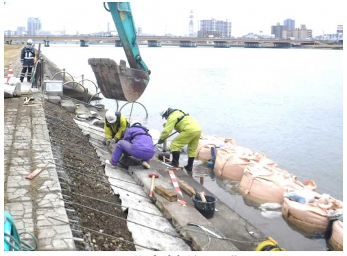
護岸補修作業
