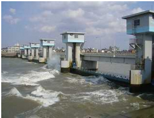
新潟大堰の全景
