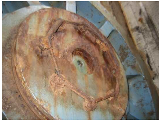
扉体主ローラ 分解整備
