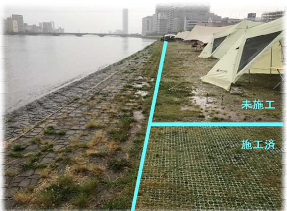
高水敷保護工の施工状況
