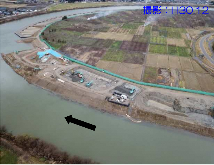
工事施工状況
