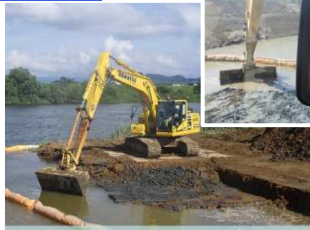
マシンコントロールによるICT掘削
