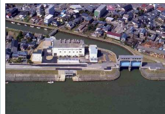
西川排水機場
