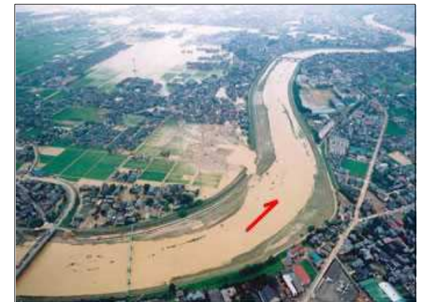
五十嵐川破堤状況(H16. 7. 14 PM撮影)
