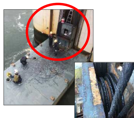
塩害による腐食の影響がある部品の更新を行う。
