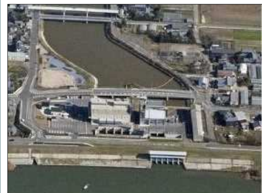
鳥屋野潟排水機場
