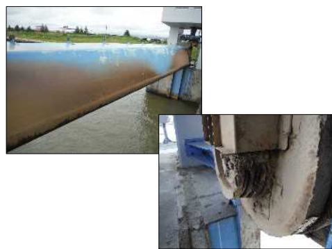
ゲートの安全動作を確保するための修繕を行う。
