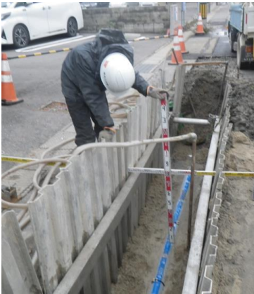
水道管設置状況
