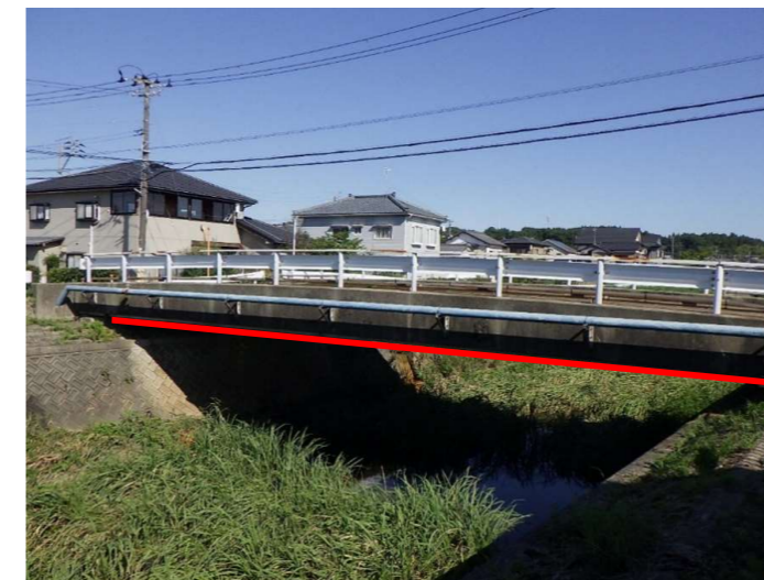
橋の底面 ひび割れ補修・表面含浸作業
