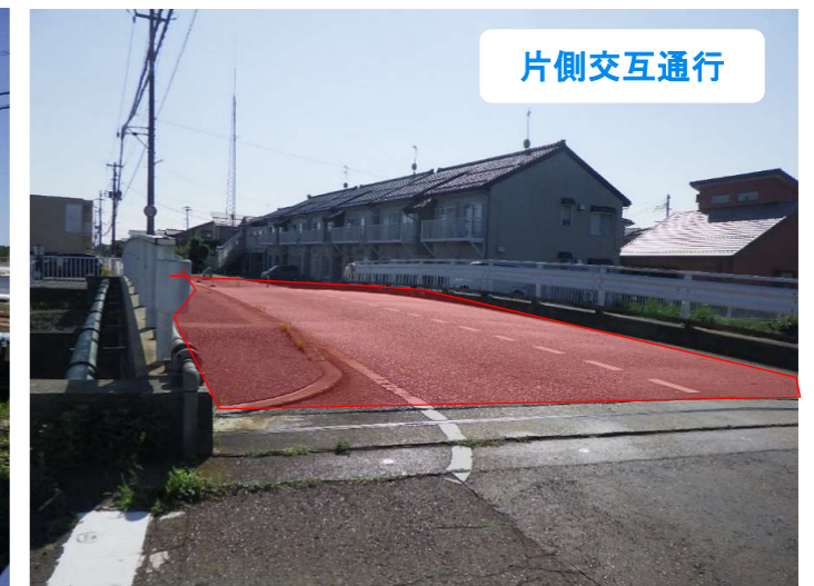
舗装下コンクリート防水作業・舗装打替え作業
