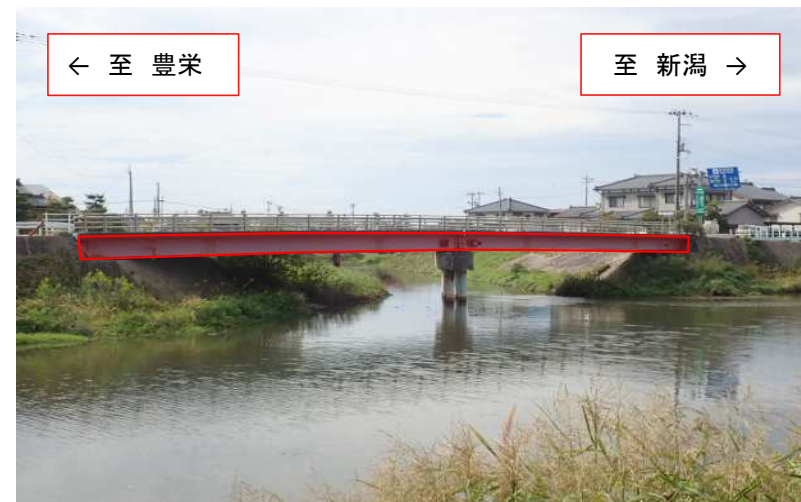
橋桁の塗装塗替
