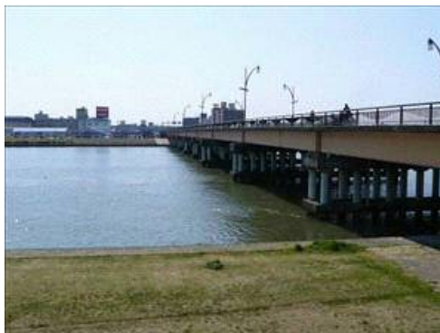
写真 2-5.1 パイルベント橋脚の例（昭和大橋）
