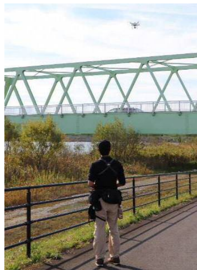
写真 2-6.5 ドローン点検の様子
