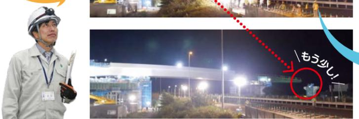
北陸自動車道上への橋げた架設工事は、長期の交通規制を避けるため、事前に組み立てた橋げたを、専用の装置で送り出すことによって、たった1晩で架設することができました。
