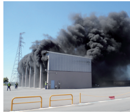
ごみ処理施設での火災の様子
