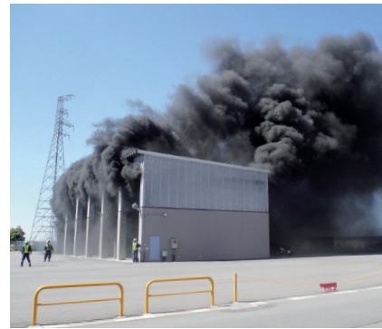
ごみ処理施設での火災の様子
