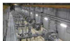
ポンプ設備更新工事
