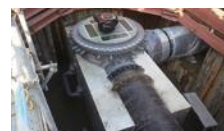
構内水管耐震化工事(不断水切替弁)
