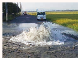
道路上の漏水
