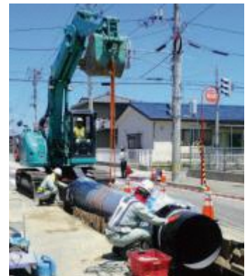
耐震管への更新
