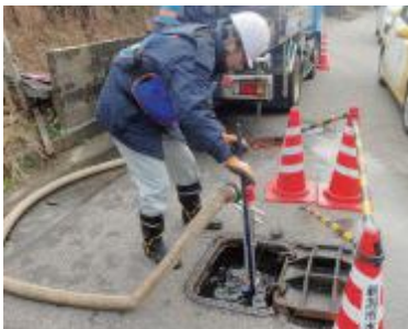
能登半島地震での復旧作業
