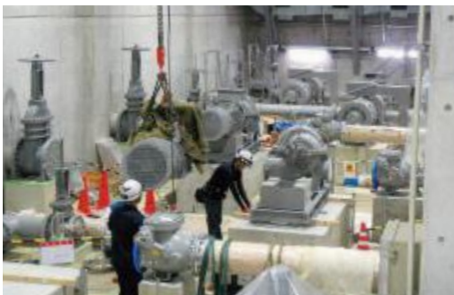
配水ポンプの更新
