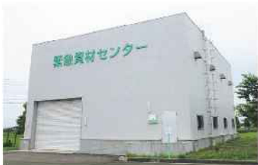
緊急資機材の備蓄基地
