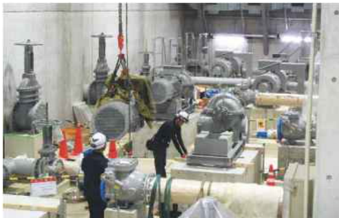
配水ポンプの更新
