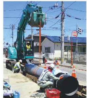
耐震管への更新
