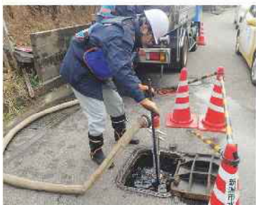
能登半島地震における石川県での復旧作業
